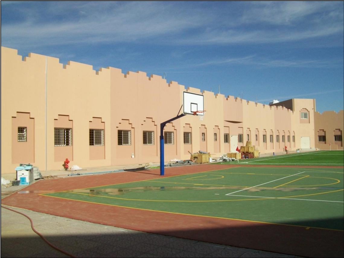
اعمال المباني الرئيسيه من الداخل
