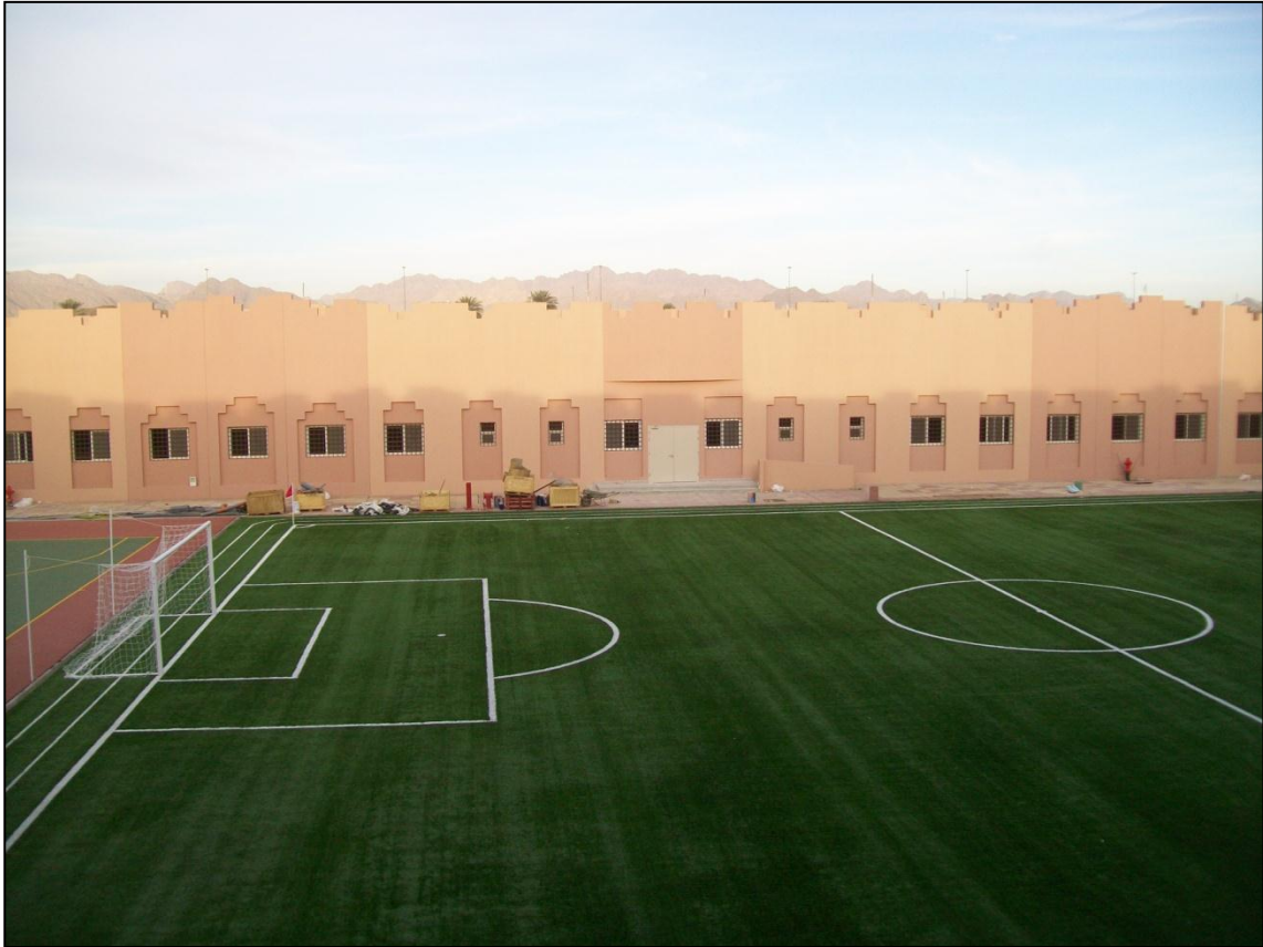
اعمال المباني الرئيسه من الداخل
