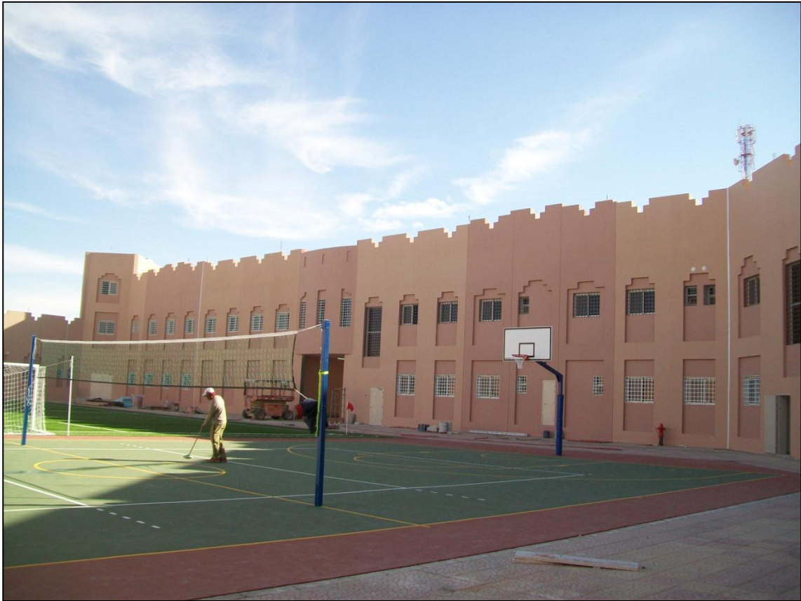
اعمال المباني الرئيسيه من الداخل
