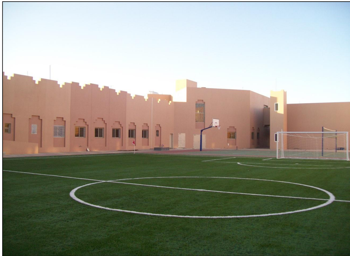
اعمال المباني الرئيسيه من الداخل
